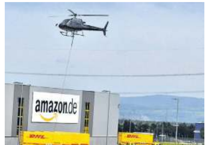
Per Hubschrauber wurden die schweren Teile aufs Dach des Logistikzentrums gebracht.
